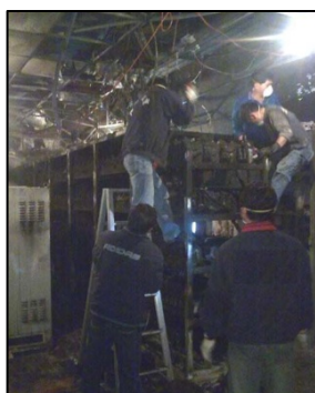
圖四 電池組火災事故
