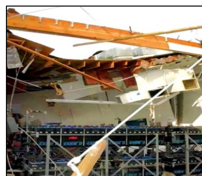
圖五 電池組氣爆事故
